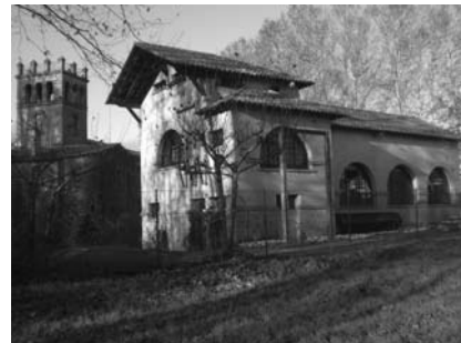
Hidroelèctrica Vinyals, Flaçà
