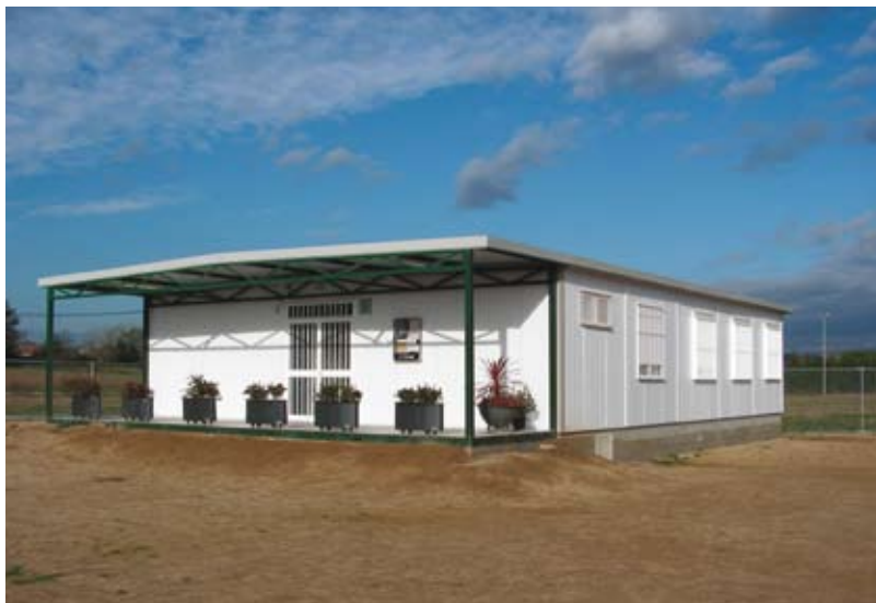
Mòdul prefabricat que acull l'institut-escola
