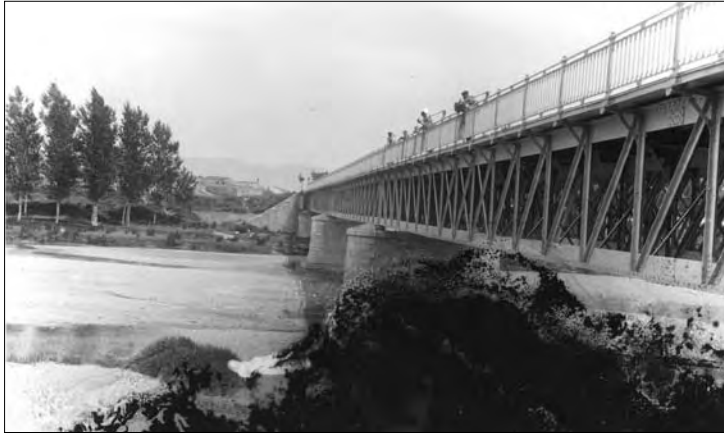
Darrers treballs de construcció del pont de Verges citat en l'article (Foto: Josep Esquirol. Arxiu Municipal de l'Escala)
